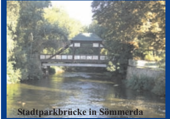
Stadtparkbrücke in Sömmerda
