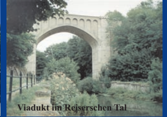
Viadukt im Reiserschen Tal
